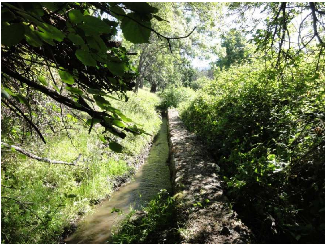
Cacera Villa, en su parte más al norte, protegida por un murete de granito.
