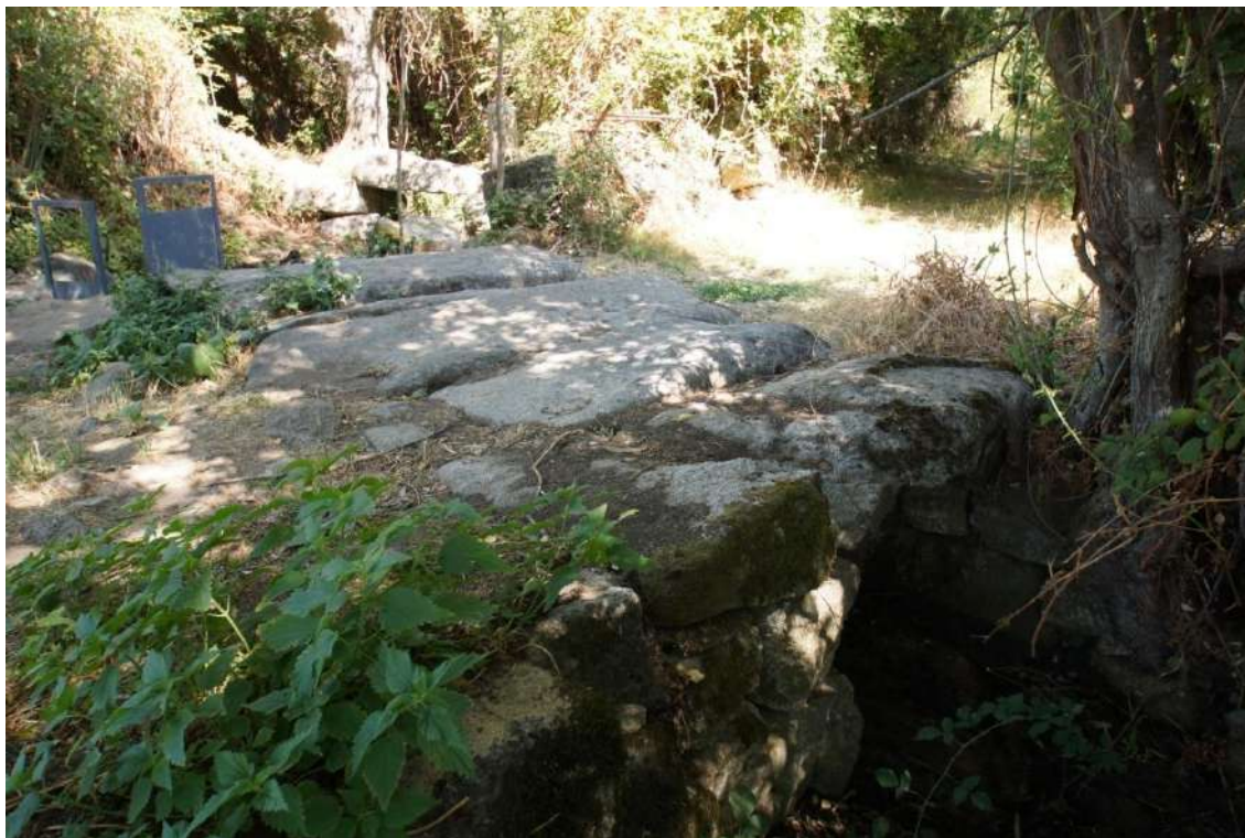
Grandes losas de granito forman el paso de la cacera bajo la hoy Calle Julio Escobar
