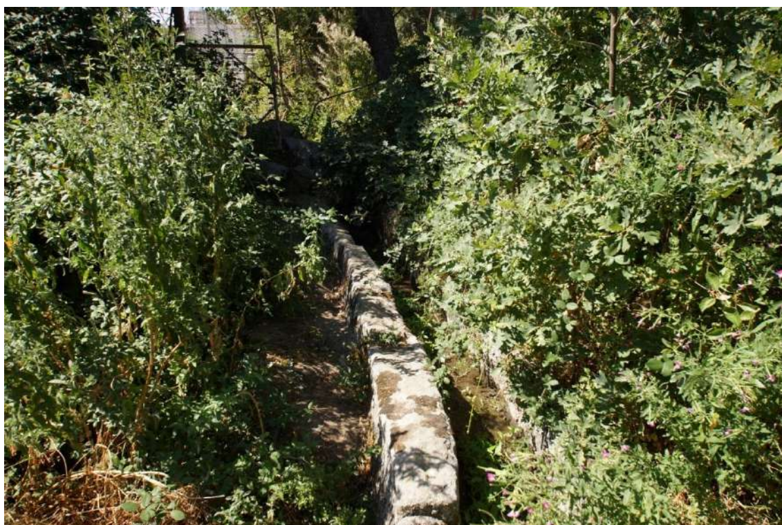
Zona de la Cacera Villa, en su parte más cercana al pueblo, encauzada entre bloques de granito.
