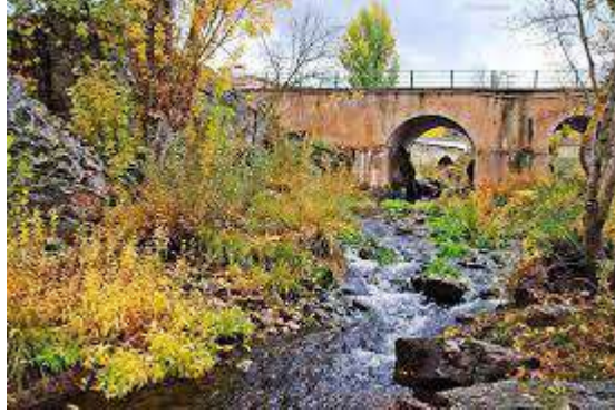
Paso del río Cega por el puente de La Velilla
